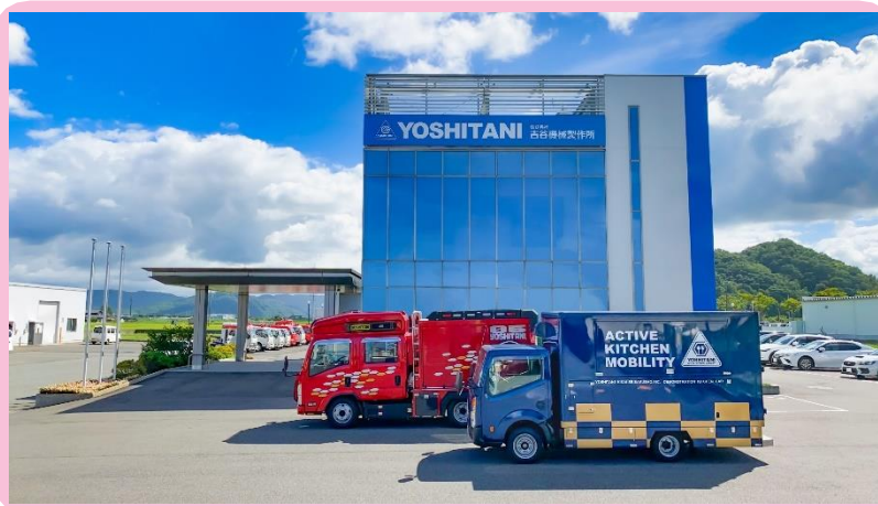
本社事務所 外観
